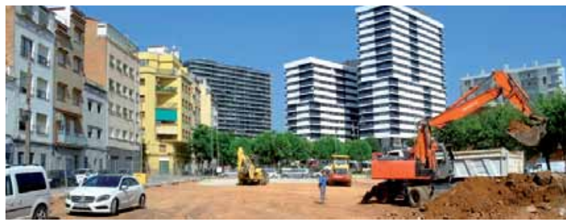
Trabajos en el solar de la calle Felip Pedrell, en la Florida
