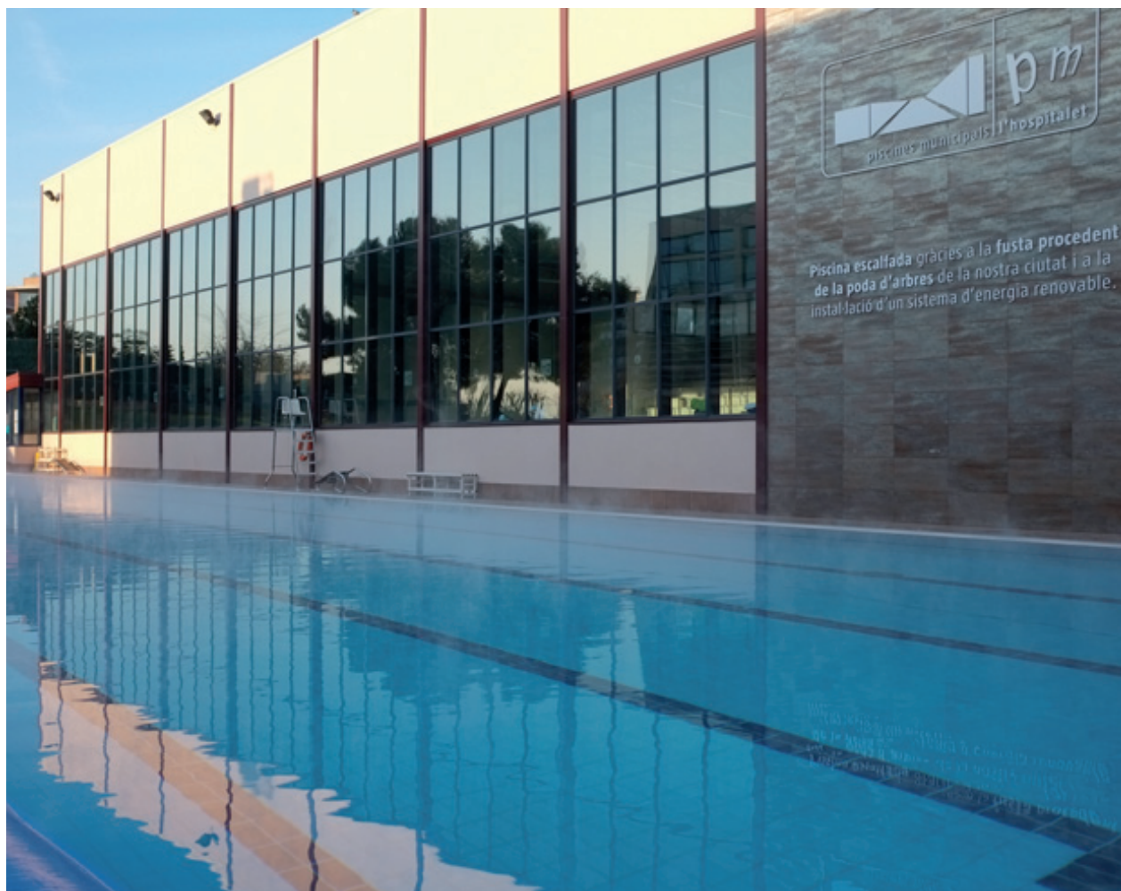
Les Piscines Municipals escalfen l'aigua amb una caldera de biomassa
