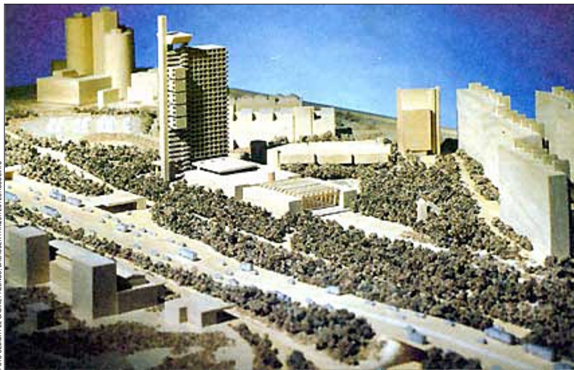
FOTO CEDIDA PEL GABINET ALONSO, BALAGUER I ARQUITECTES ASSOCIATS
