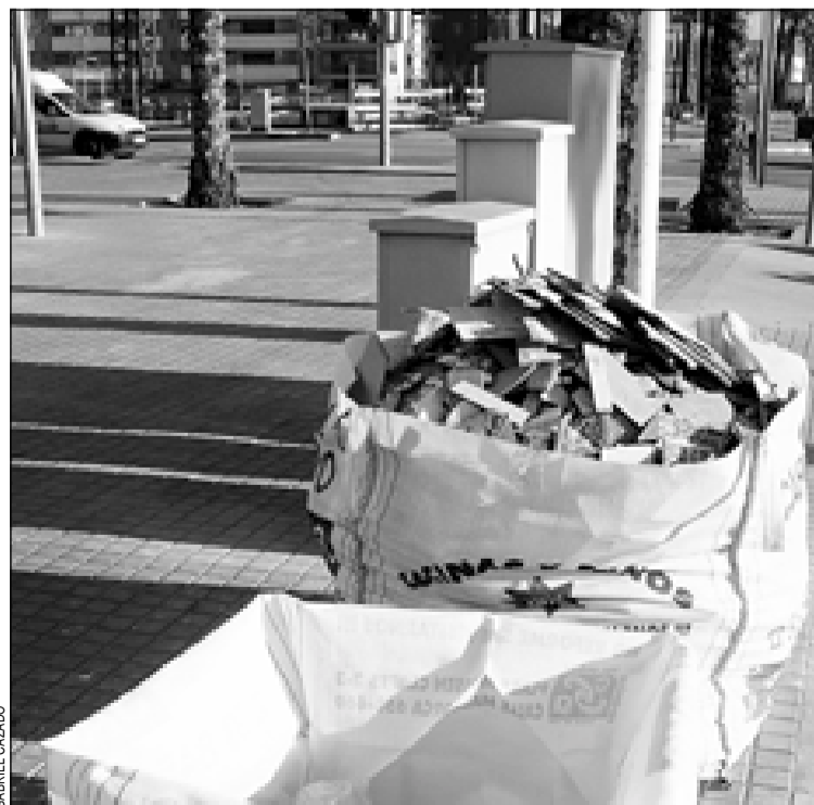
Els sacs de runa tenen imprès un telèfon per a recollir-los
