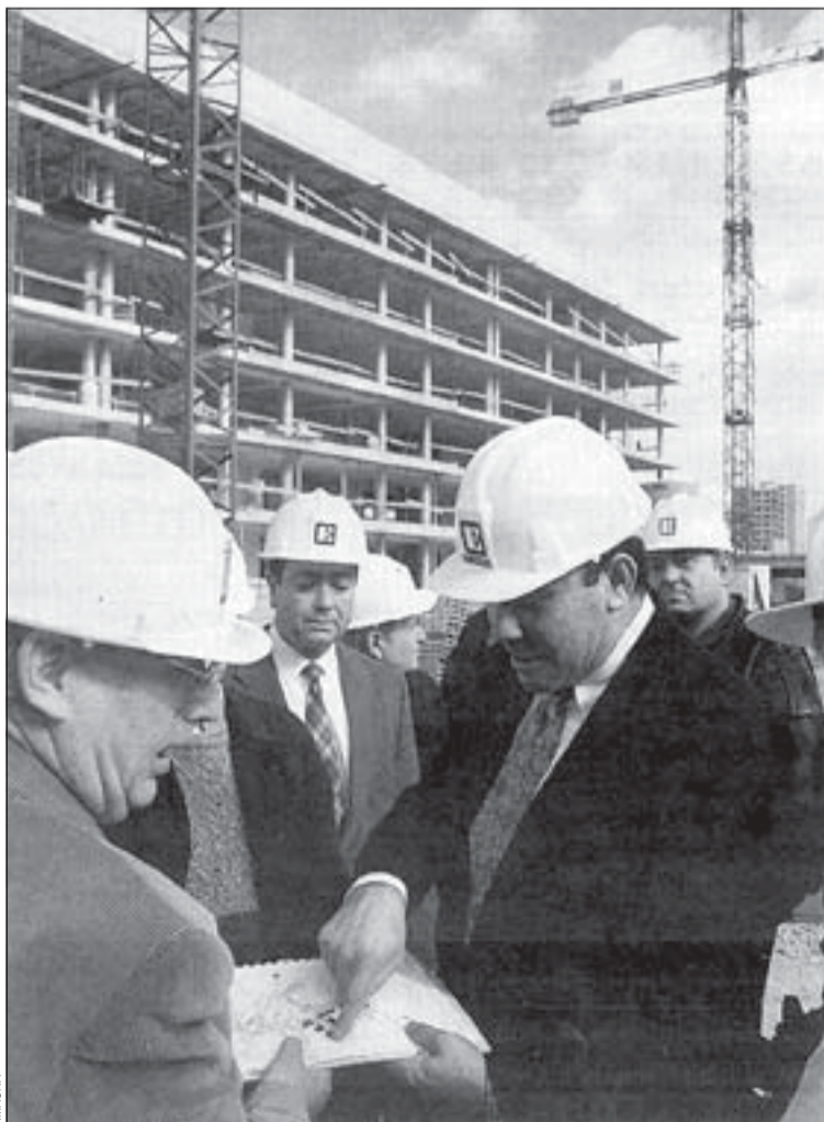
Los miembros de la Comisión de la Vivienda visitaron las obras
