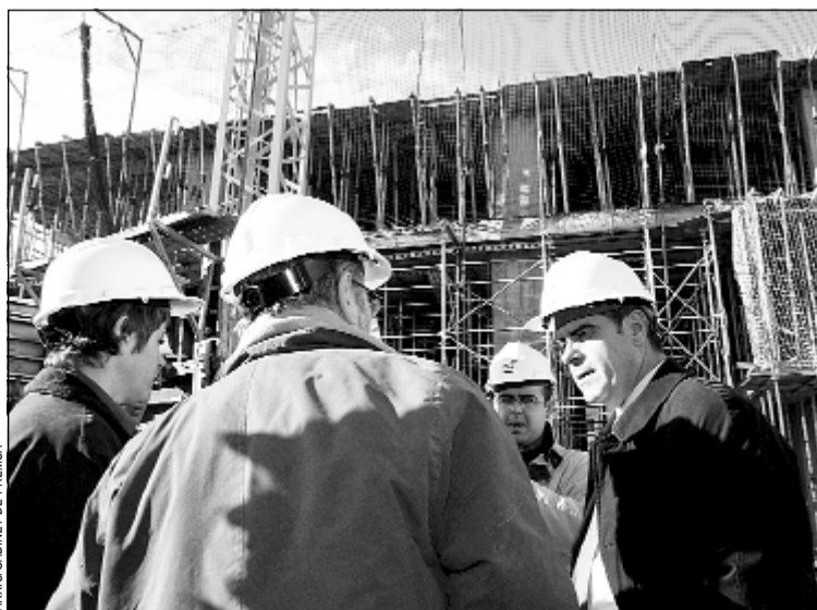
Corbacho y Molina visitaron las obras del nuevo edificio
