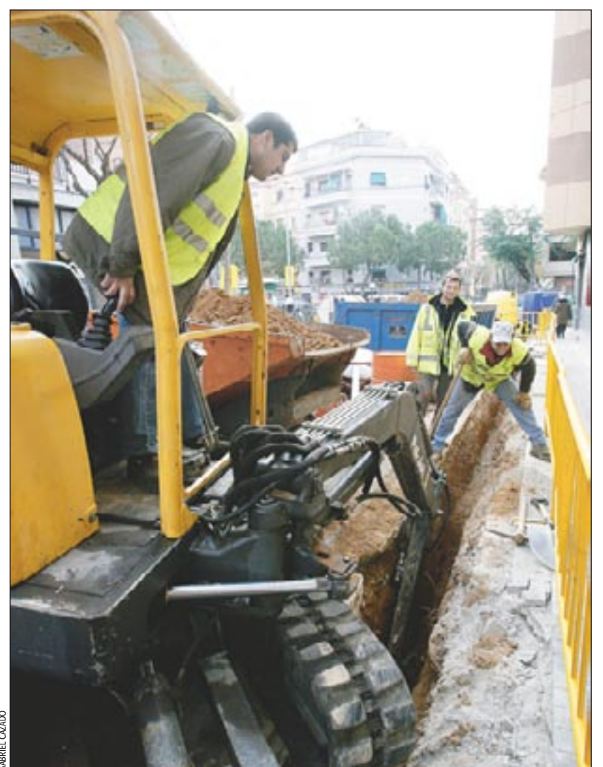
Las máquinas empiezan a trabajar en la calle de Belchite
