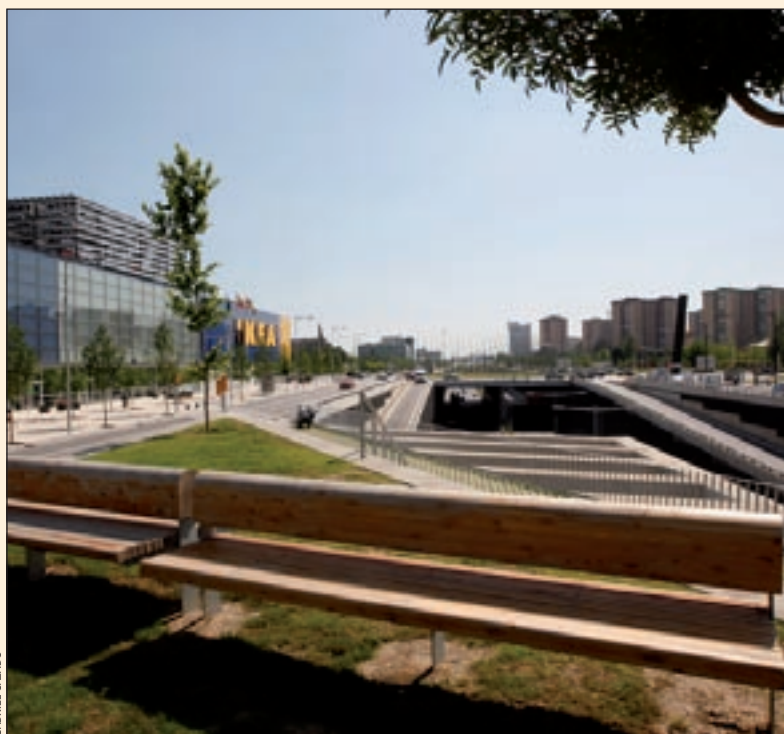
La nova Granvia, amb la calçada deprimida
