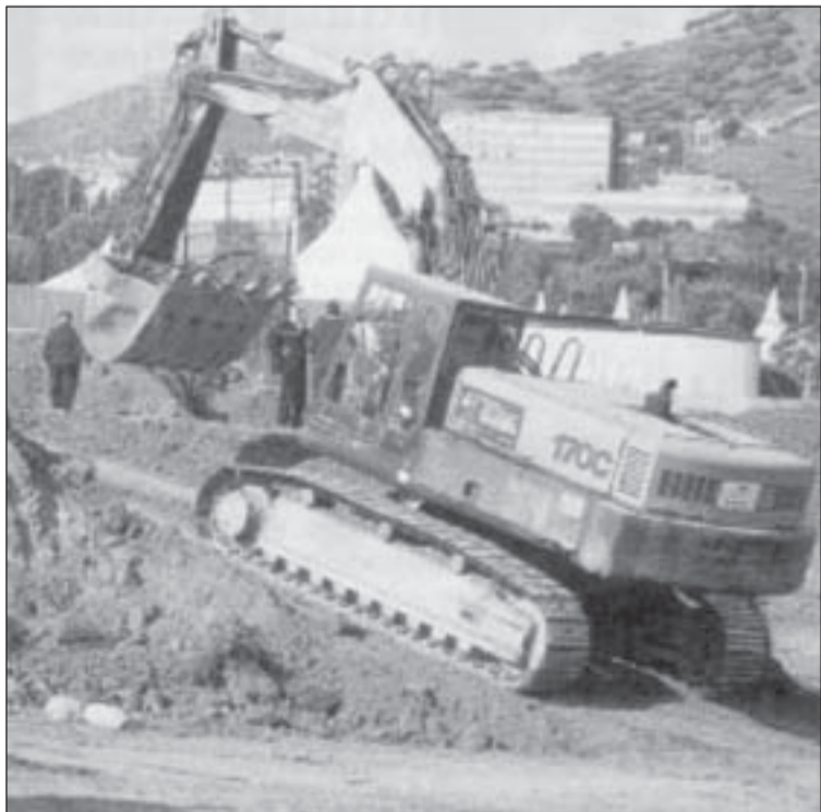
En la zona ya se han iniciado los primeros trabajos
