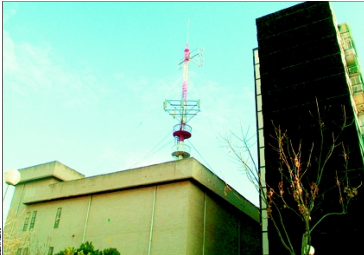
Telefónica ha anunciado que desmantelará parte de la antena de Bellvitge
