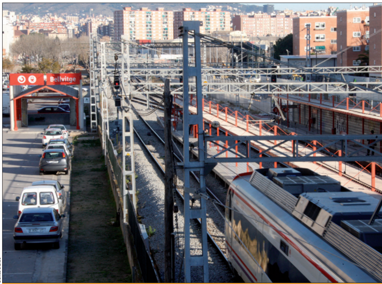
Se soterrará la estación de Bellvitge, que actualmente está en la superficie
