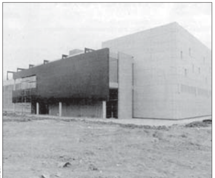
El edificio del tanatorio está recubierto con placas de aluminio
