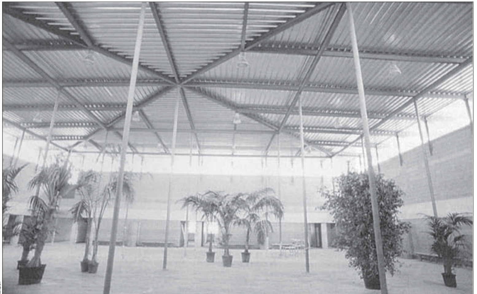
El edificio del Tanatorio, diseñado por el arquitecto Pere Mora, cuenta con un claustro central ajardinado con luz natural
