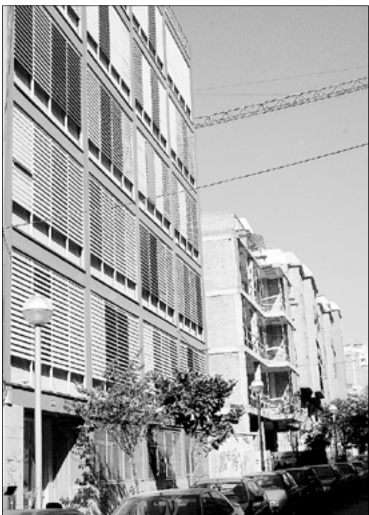
El antiguo edificio del Patufet se está remodelando
