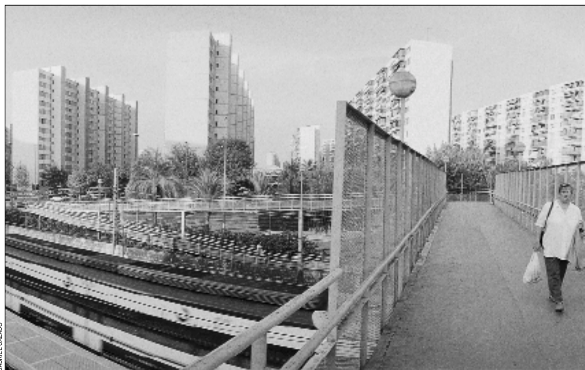
Con el soterramiento de las vías desaparecerán los puentes como éste
