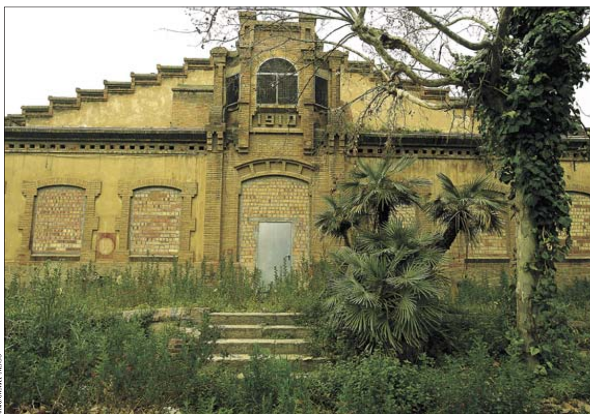
Antiguo edificio modernista de Can Gras en el recinto de Can Trinxet
