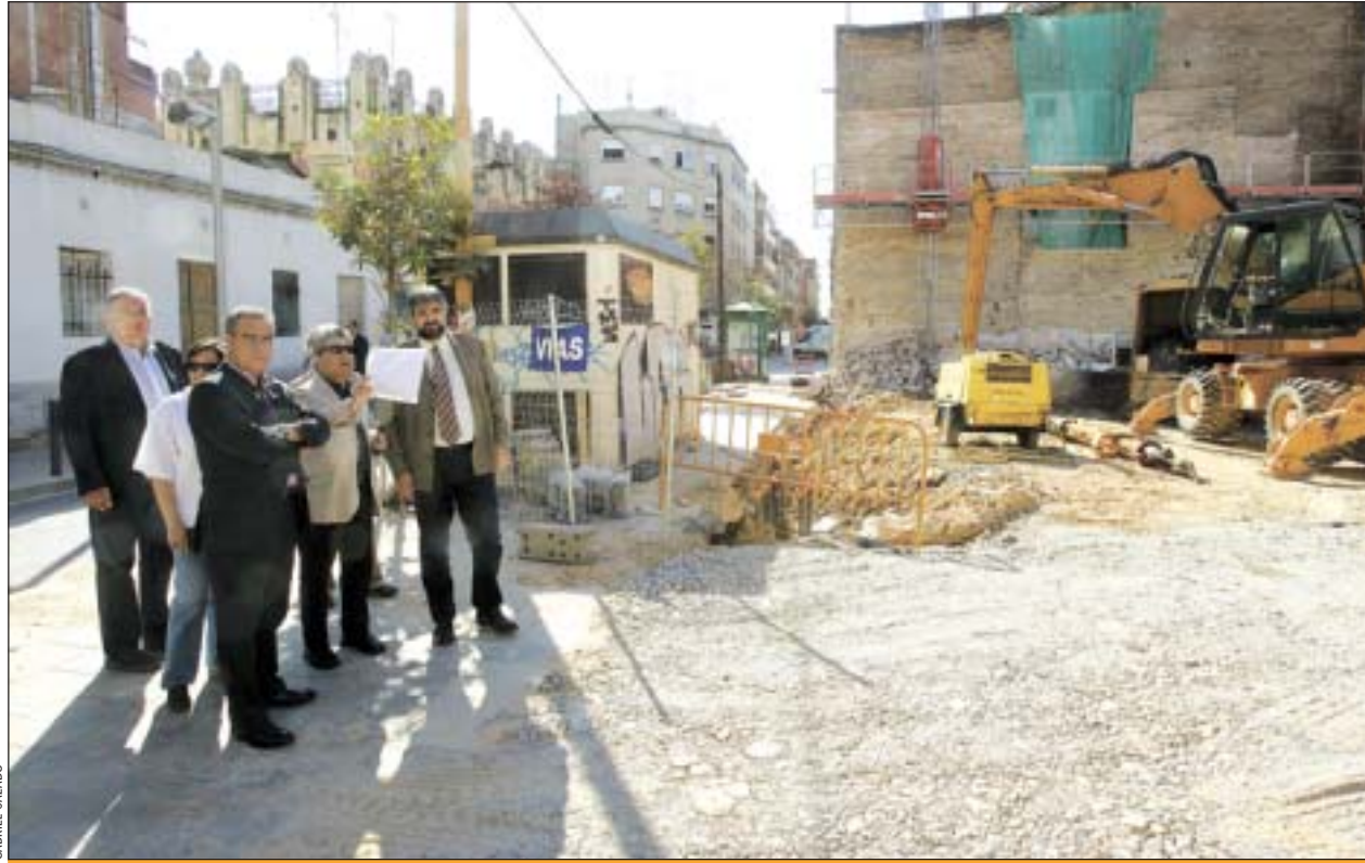
Técnicos municipales dan detalles de las obras al alcalde y al concejal del distrito
