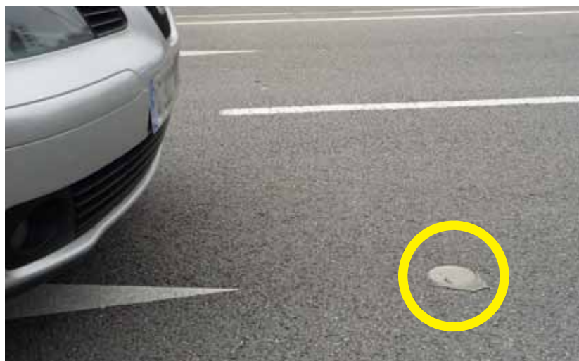
Al cercle groc, un dels sensors de control al carrer d'Amadeu Torner
