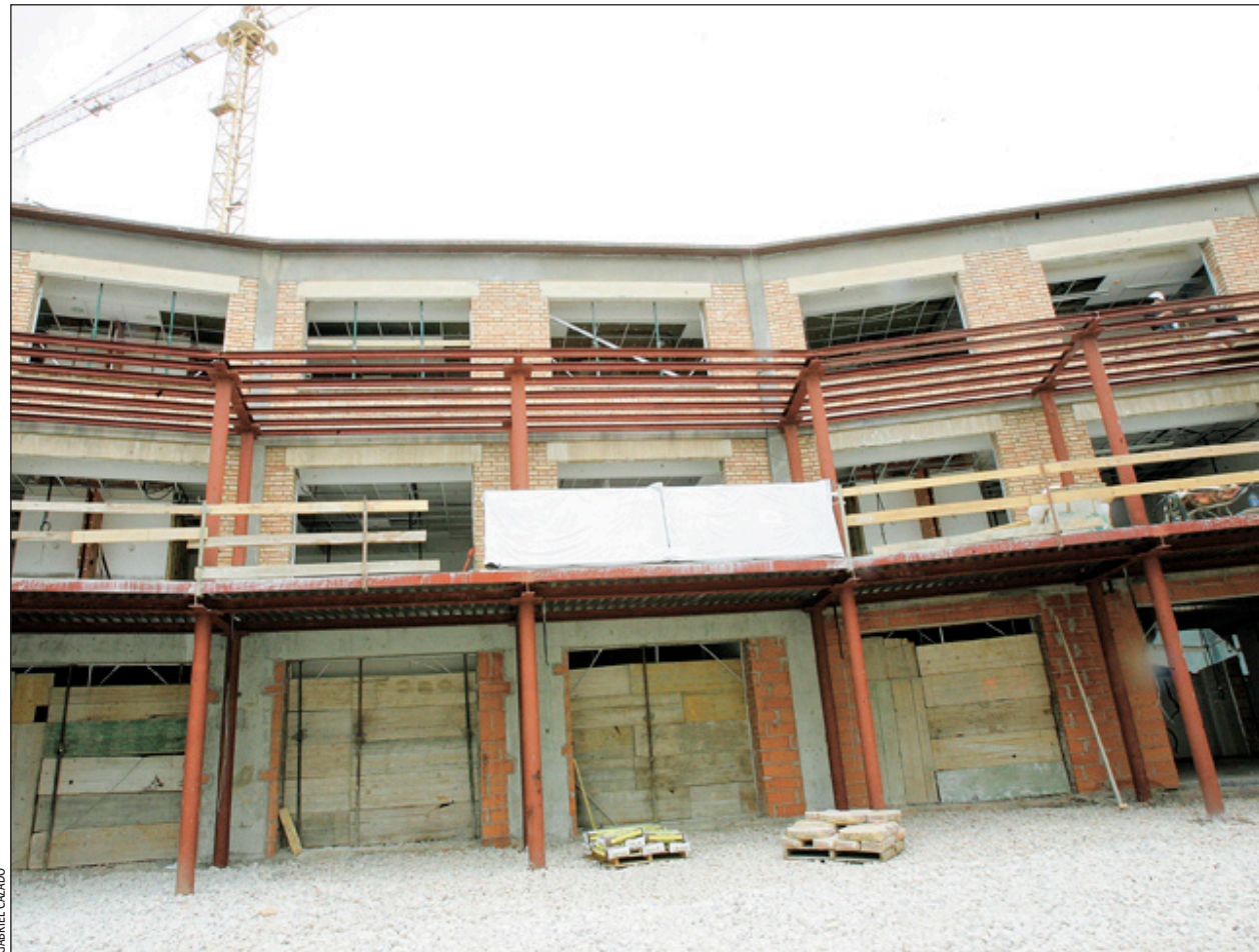
La Casa del Molí en obres per adequar-la a les necessitats de la nova escola bressol
