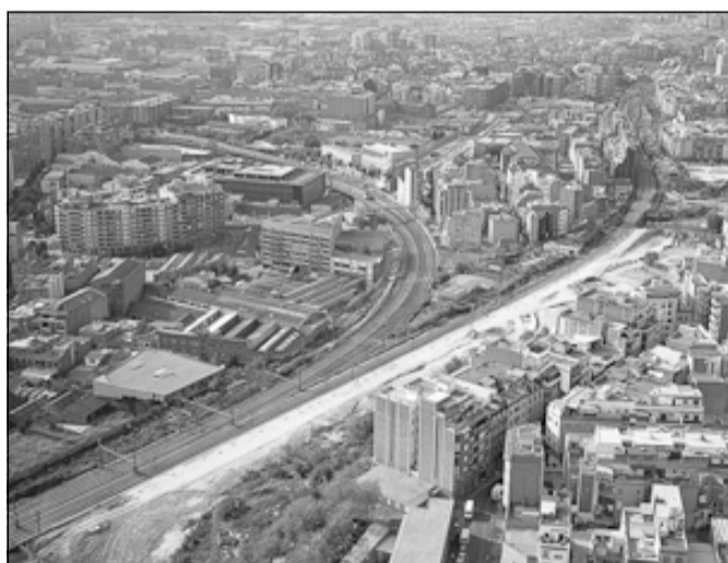
Las vías antes de construirse el parque de la Torrassa
