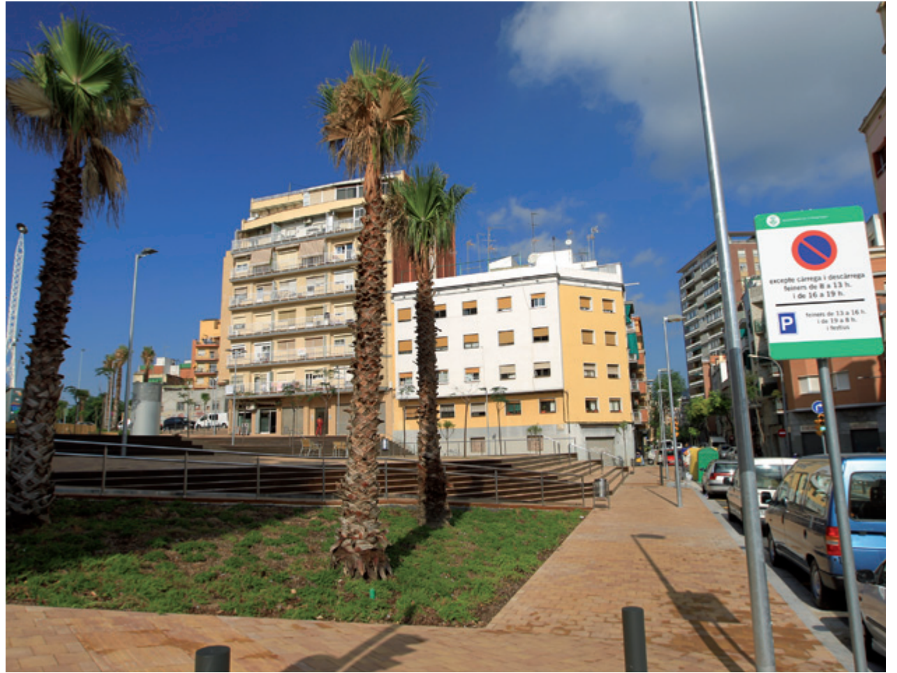
Estado del tramo norte de la avenida de Catalunya, tras la urbanización
