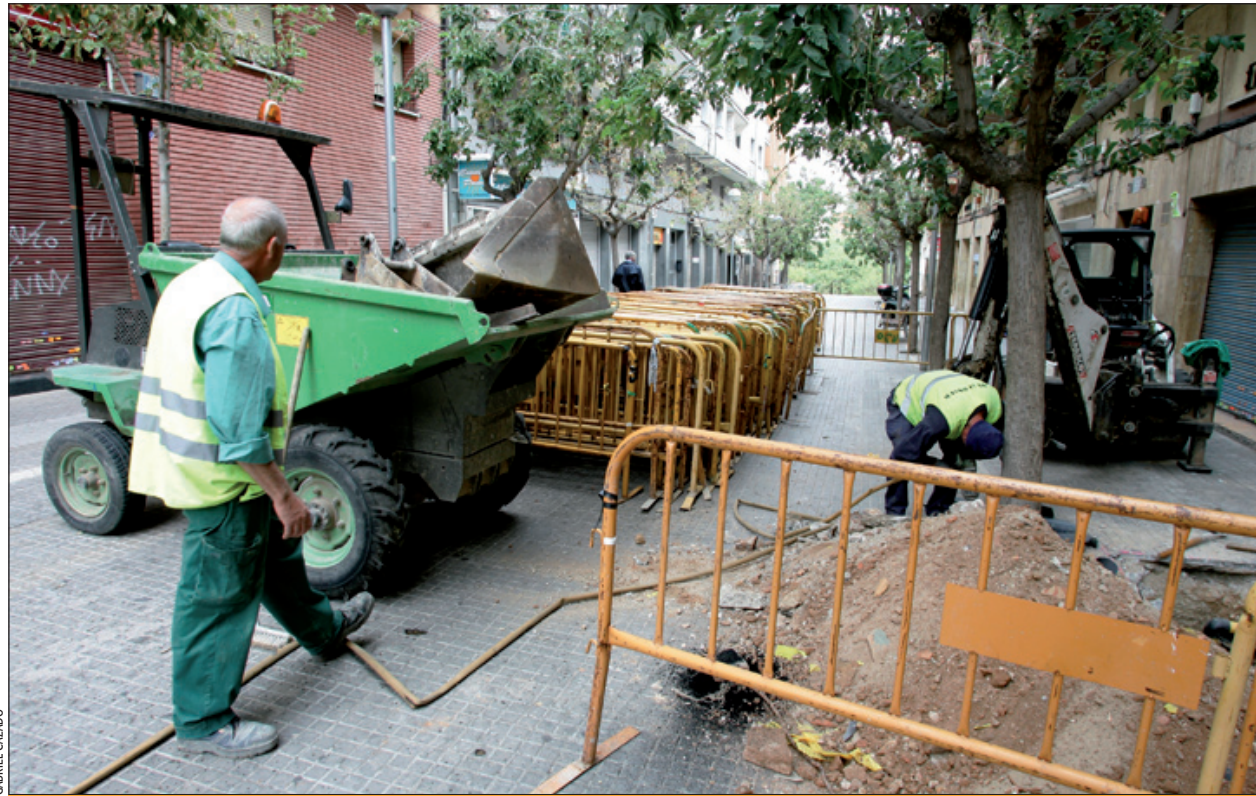
Obres prèvies per iniciar els treballs de construcció del nou vestíbul de Can Vidalet
