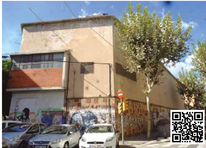
Estado actual del edificio de L'Òpera
