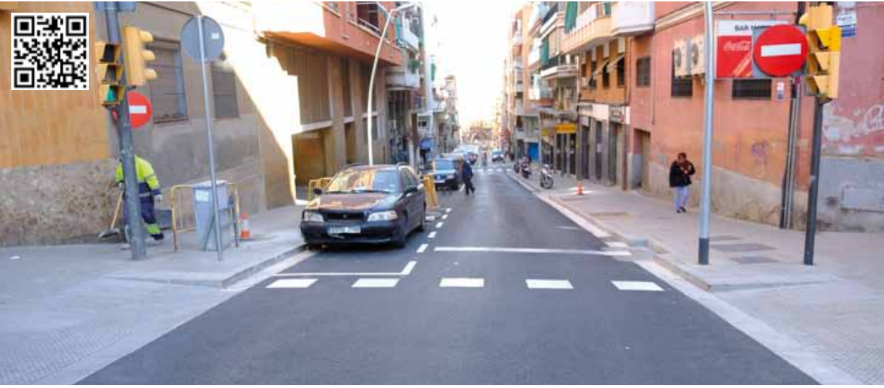
Cruce con semáforos y aceras adaptadas en Rambla Catalana
