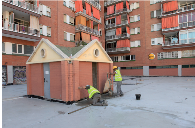
Obres de rehabilitació de la plaça d'Escorça, a Santa Eulàlia
