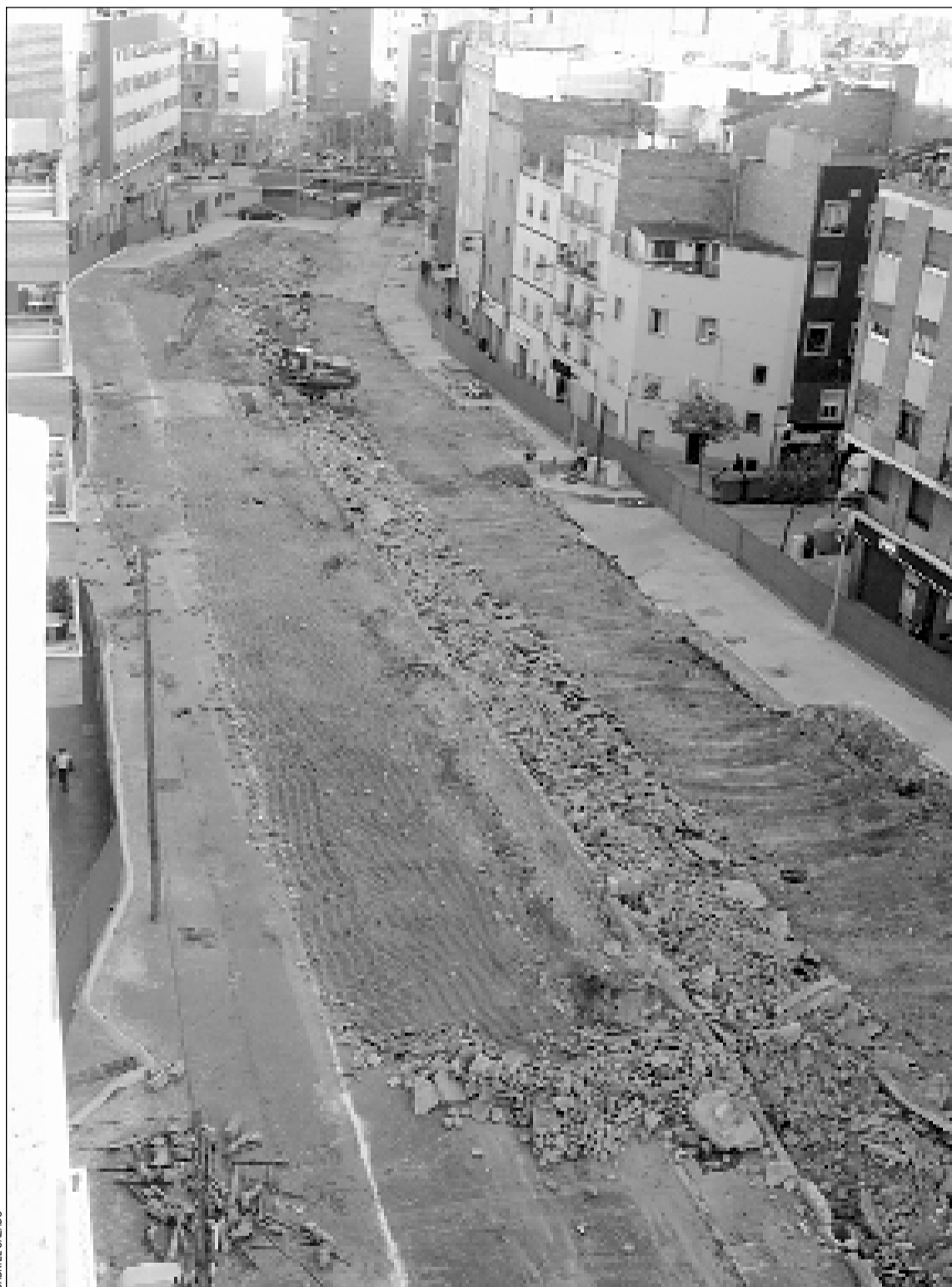
Las obras del p rquing municipal de Severo Ochoa, entre Isabel la Cat lica y Calder n de la Barca
