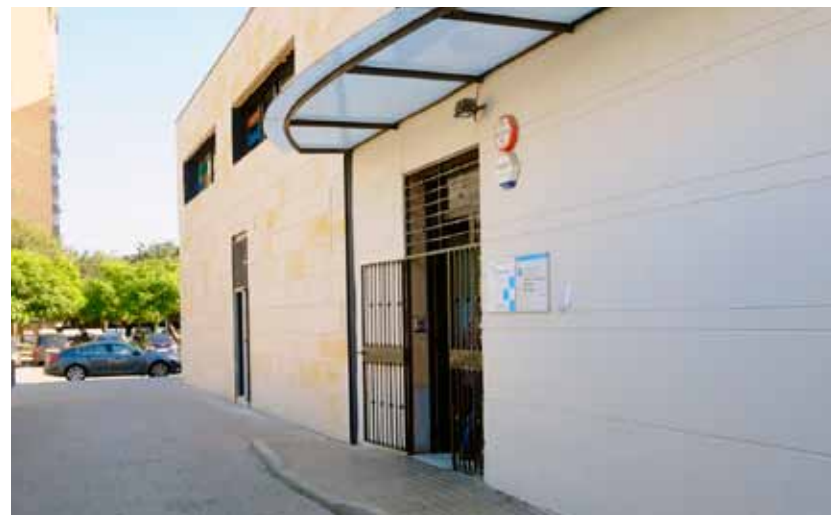
Instalaciones provisionales del CAP de Gornal
