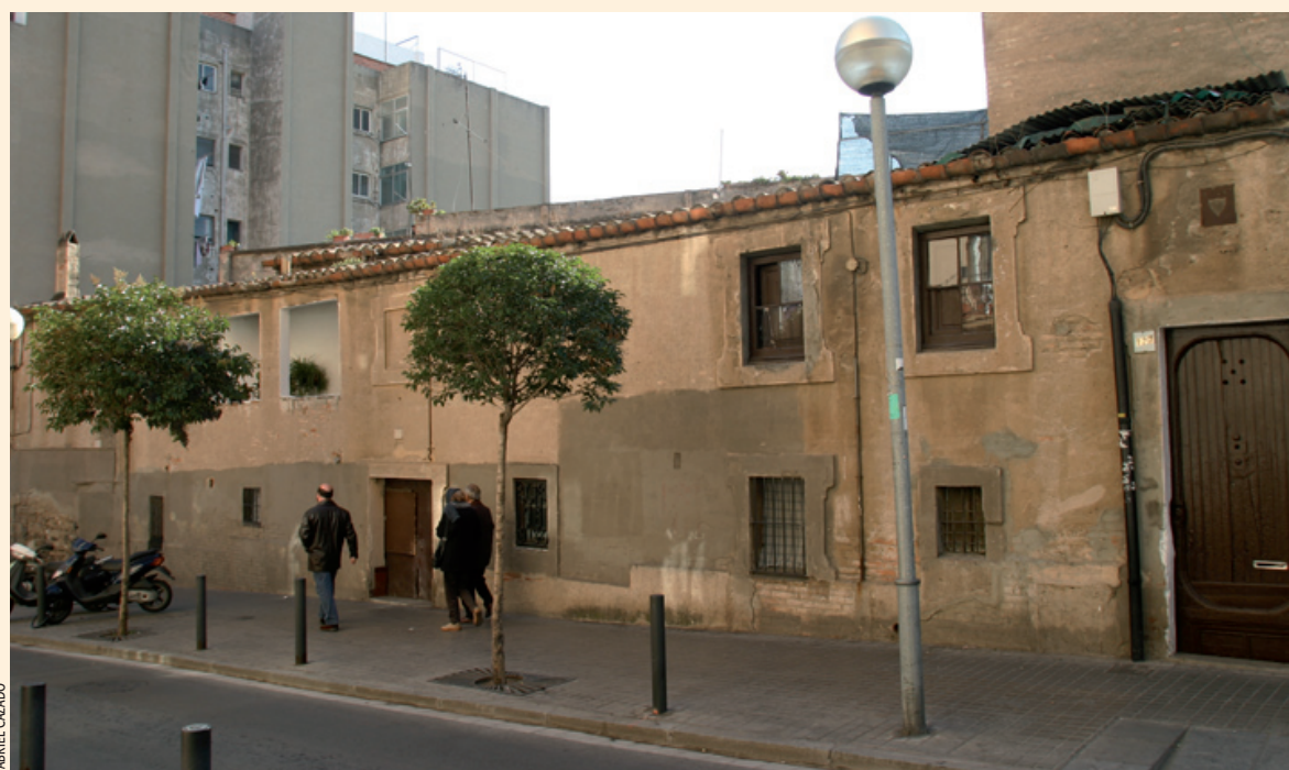
La façana de la casa de la Torrassa amaga el mur d'un castell medieval
