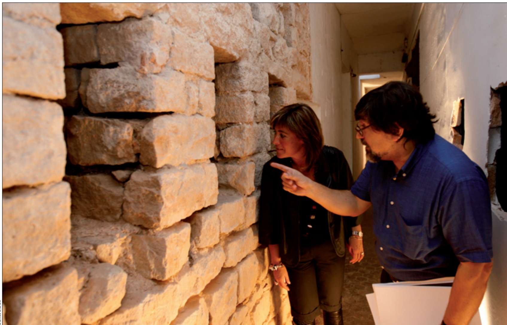
L'alcaldesa, Núria Marín, observa la paret del castell, un mur de 20 metres de llarg
