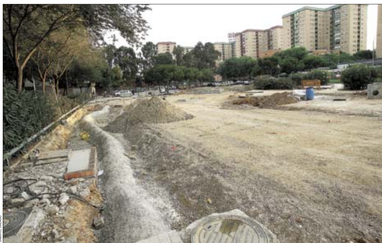
El colector de la rambla Carmen Amaya, en el Gornal, se ha cubierto recientemente
