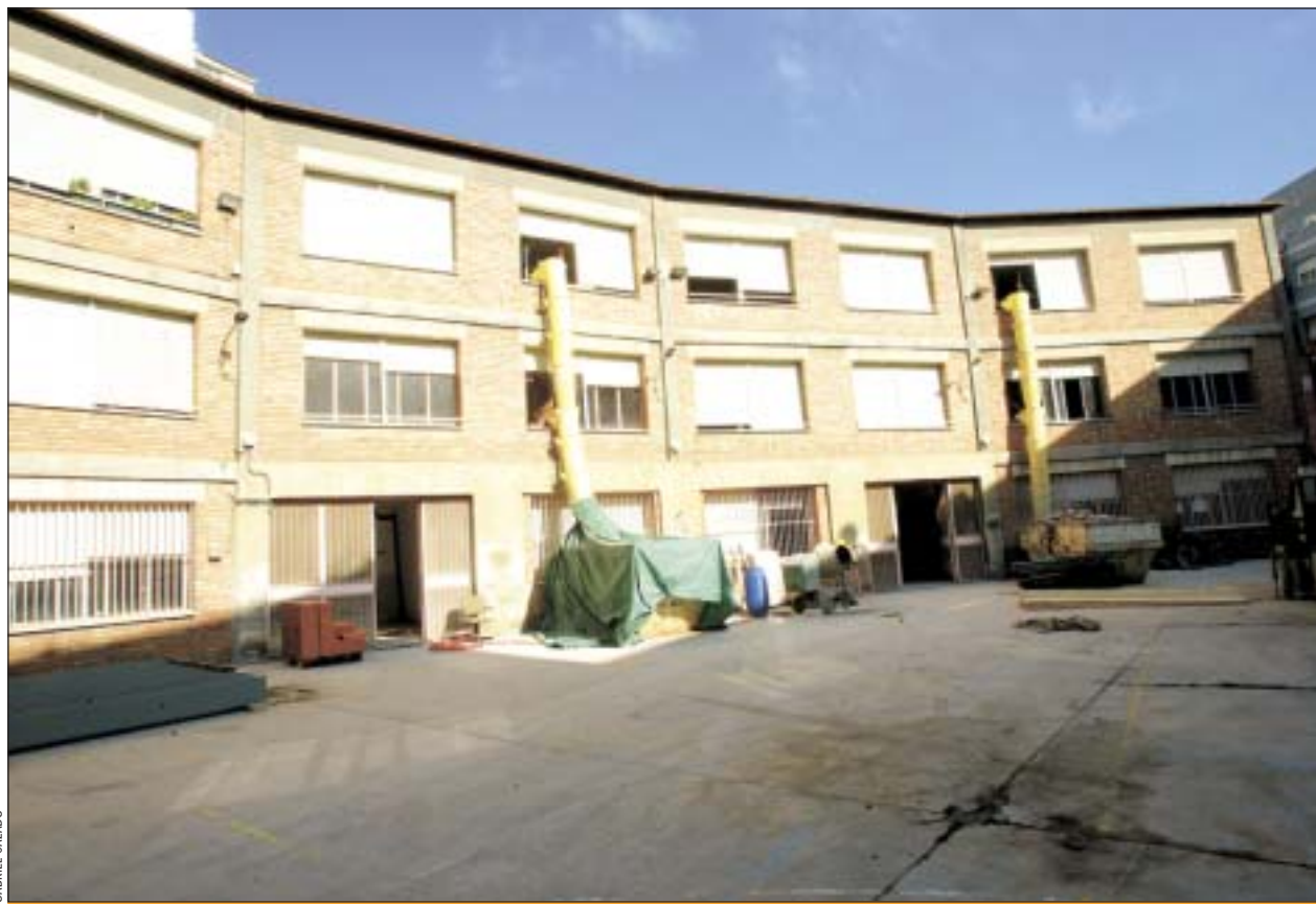
Se han empezado las obras para reconvertir el Joaquim Costa en una guardería pública
