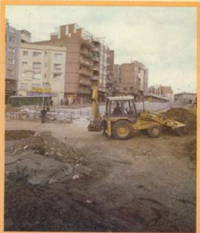
Inversió: 200 milions Finalització de obres: marzo de 1995 Projecte: espacio urbano
