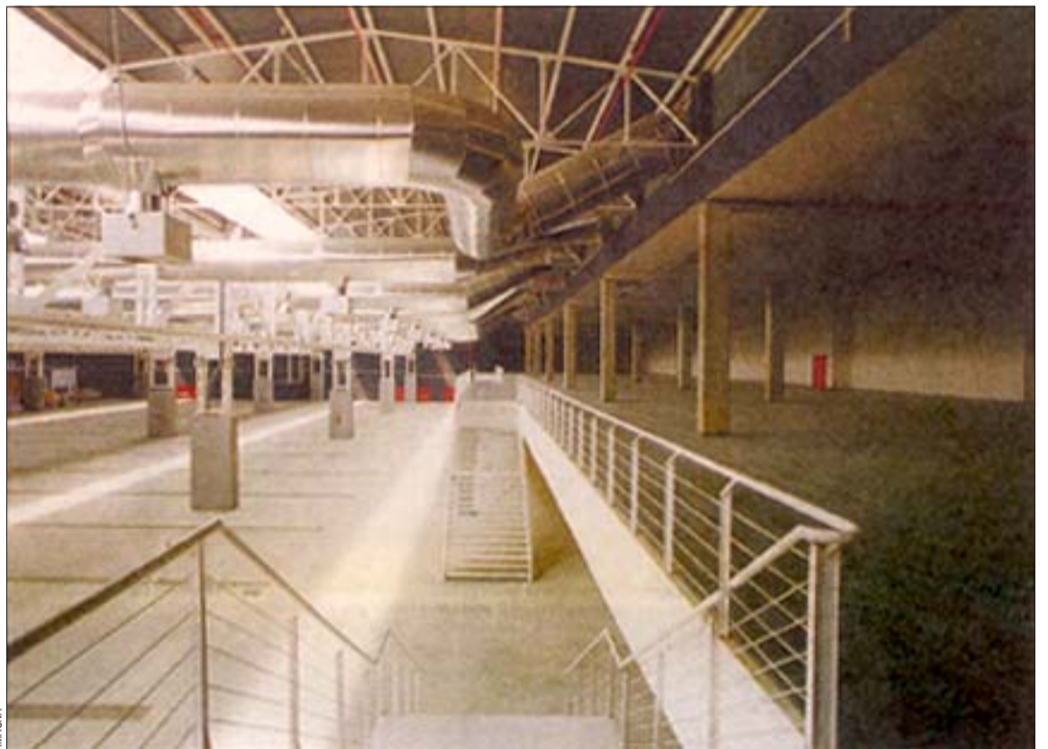
En este espacio de La Farga se construyen cuatro auditorios
