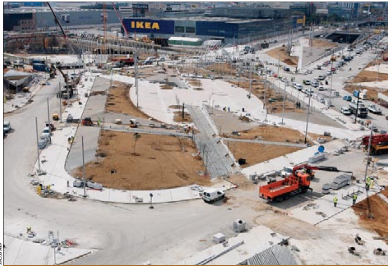
Perspectiva de la plaza de Europa durante la finalización de las obras
