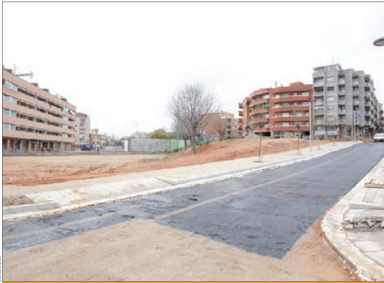
Obres d'arranjament del carrer de l'Estronci, que arribarà fins a Esplugues
