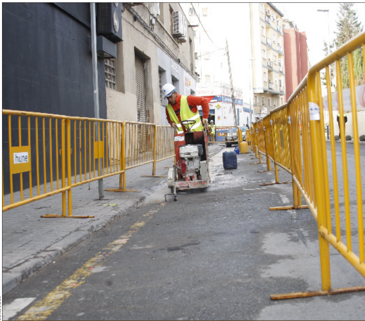
Obras de mejora en una de las aceras de la Travessera de Collblanc
