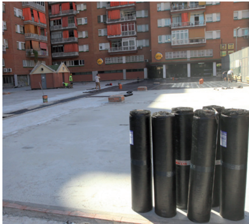
La plaça de l'Escorça actualment en obres
