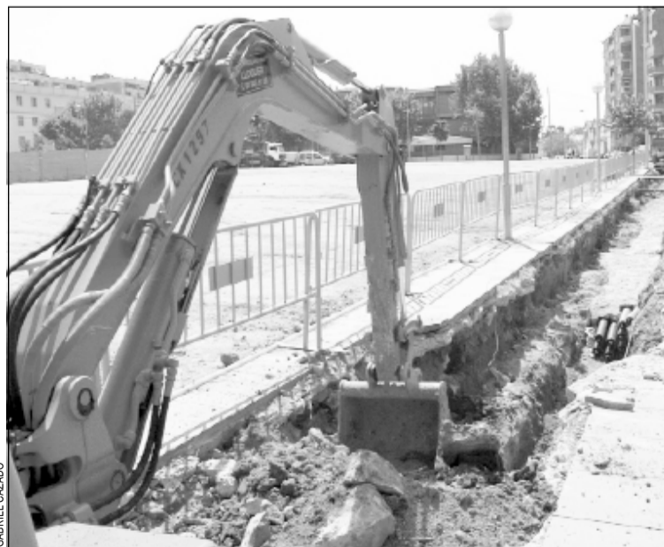
Obras de instalación de cable en Santa Eulàlia
