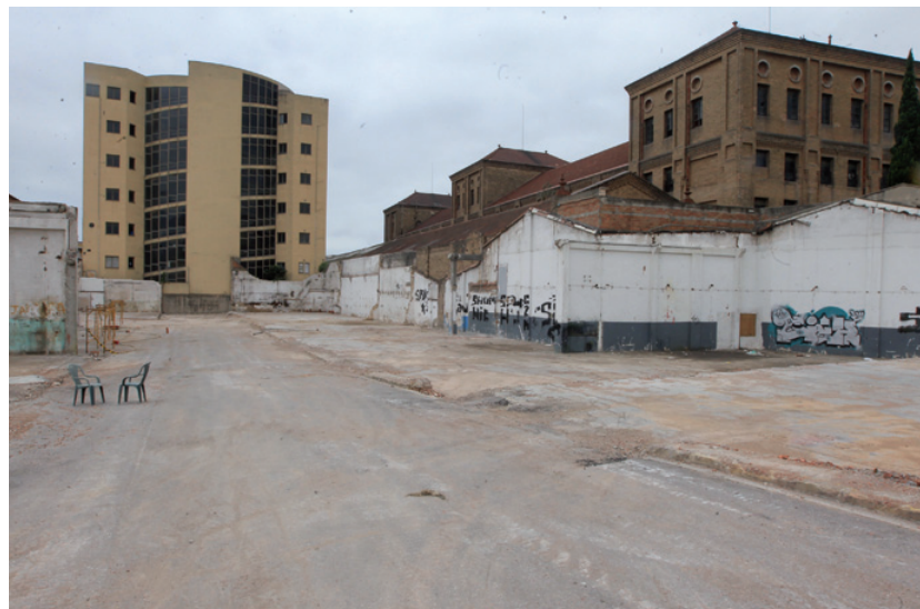
Solar de l'illa Cosme Toda un cop derruïdes les naus que l'ocupaven
