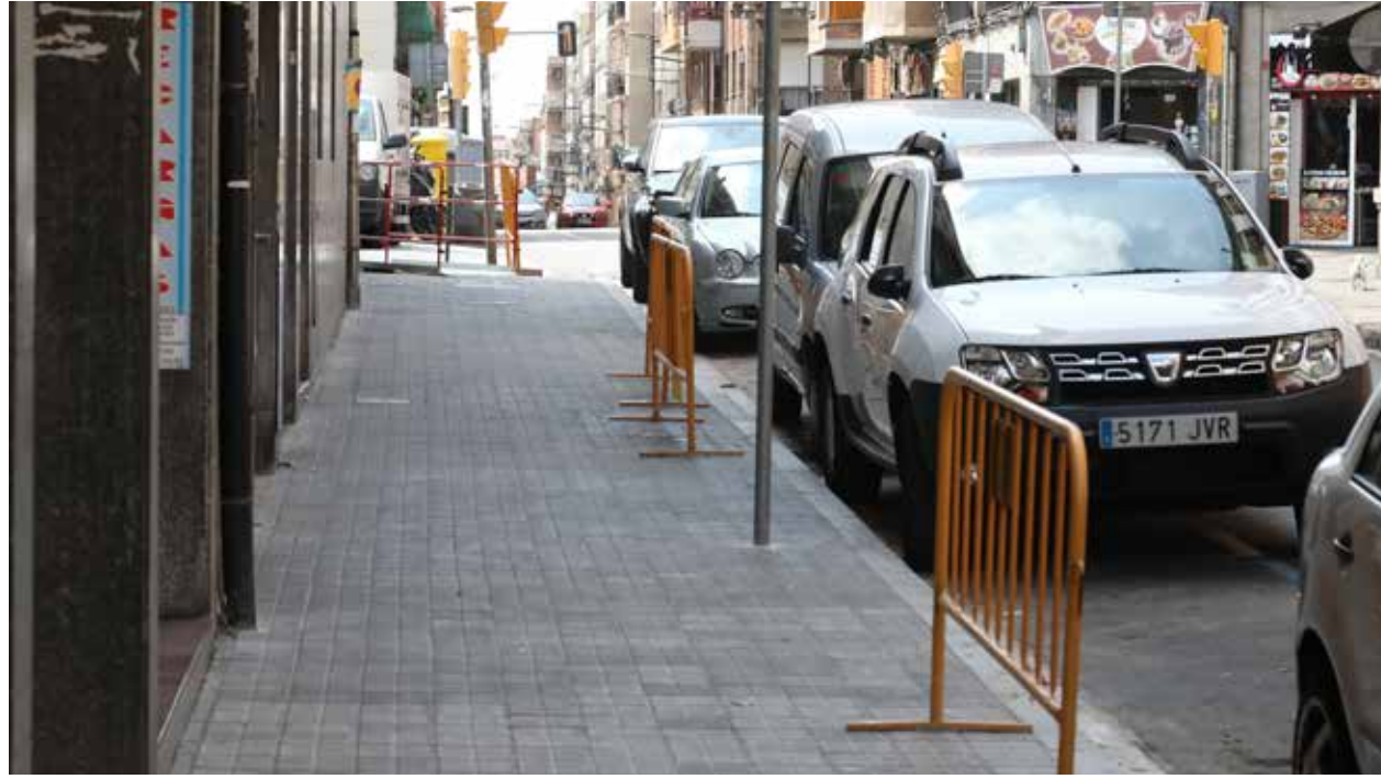
Nuevo pavimento y más anchura para la aceras de la calle Montseny, entre Rafael Campalans y Llobregat
