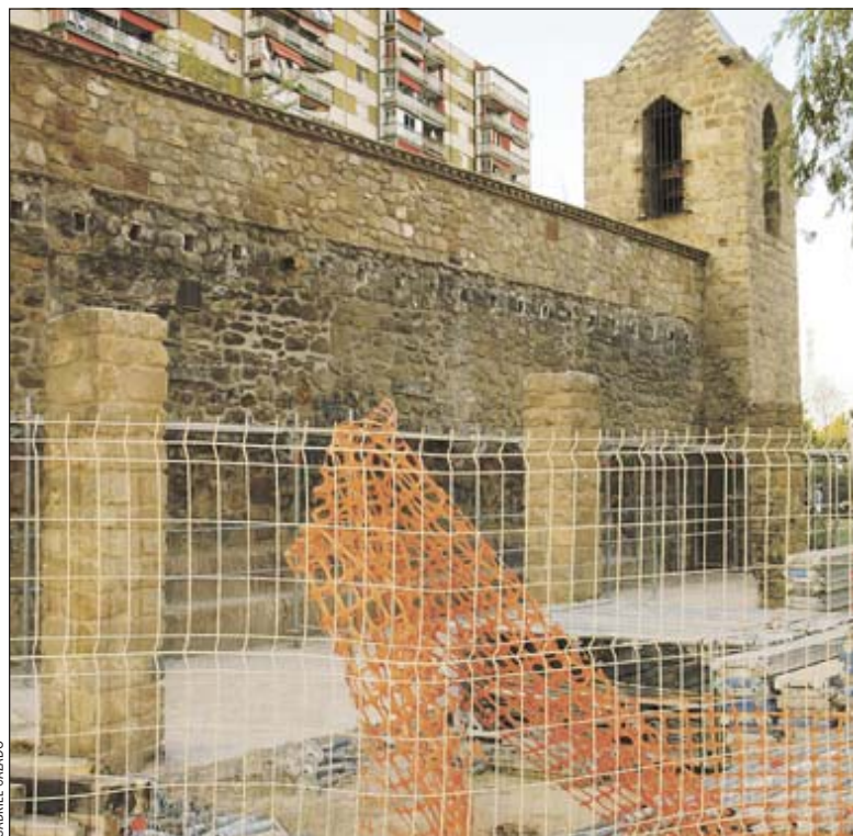
Ja han començat les obres de rehabilitació
