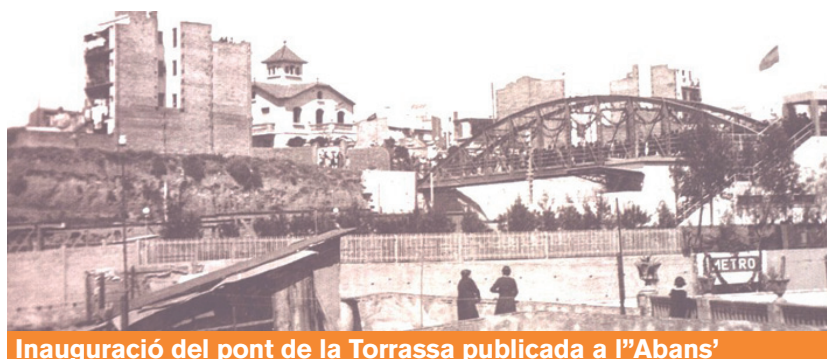
Inauguració del pont de la Torrasa publicada a l'"Abans"
