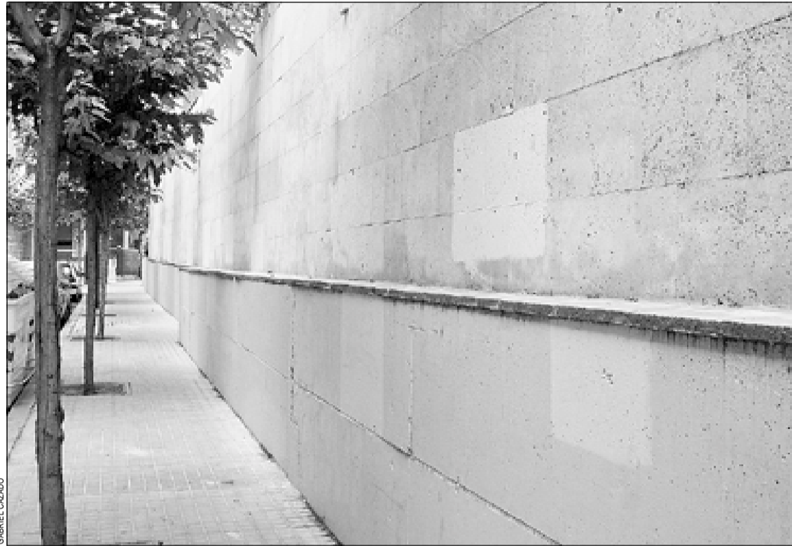
La calle Ramón y Cajal de Santa Eulàlia es una de las zonas rehabilitadas
