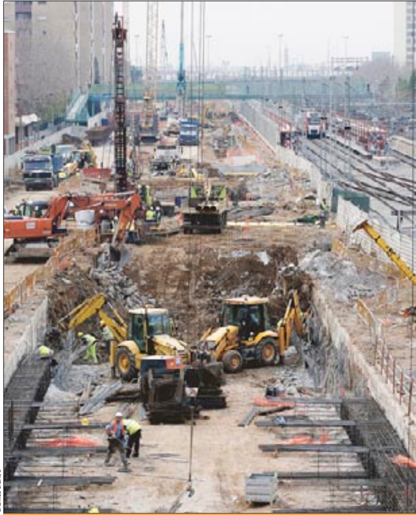
Obras del AVE junto a las líneas de Cercanías
