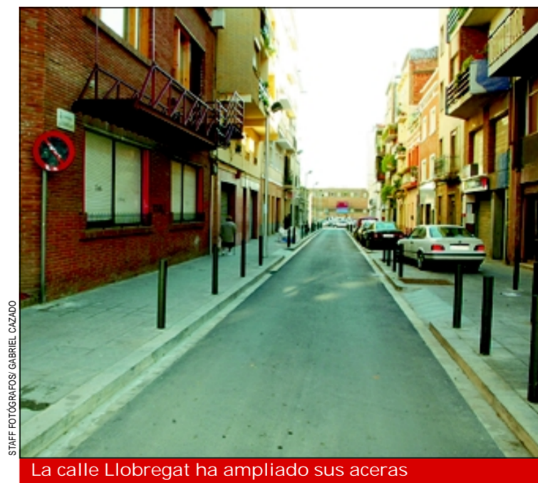
La calle Llobregat ha ampliado sus aceras
