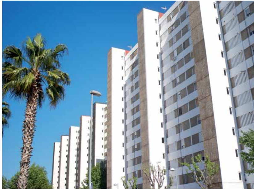
Edificio de Bellvitge que recibió ayuda del AERI en 2012
