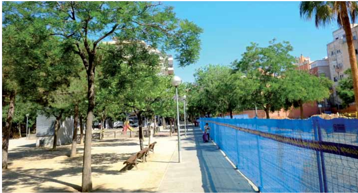
Les obres es fan en diferents fases per no eliminar tota la zona de passeig
