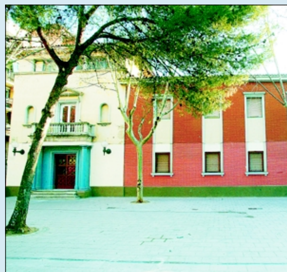
Vigilancia de fachadas recuperadas
