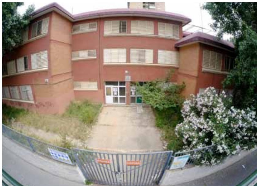
Les obres ja han començat a l'antic centre escolar Pla del Llobregat
