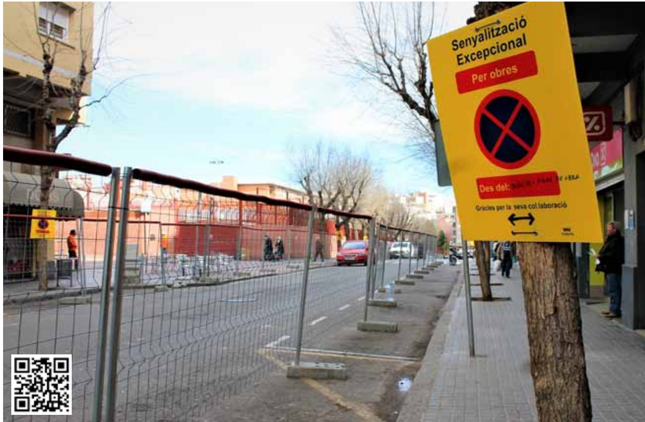
Las obras incluyen la ampliación de las aceras y la reordenación del área de aparcamiento
