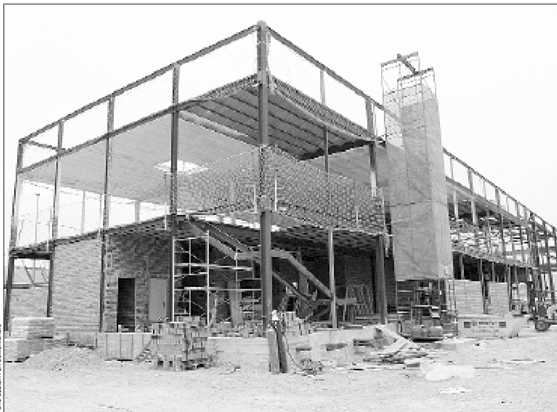
Las obras del Parc de Sanejament de la calle Arquímedes finalizarán hacia finales de año
