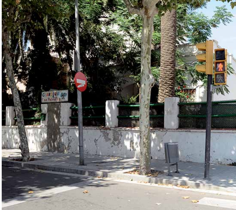
Construcción tapiada en la calle Pedraforca
